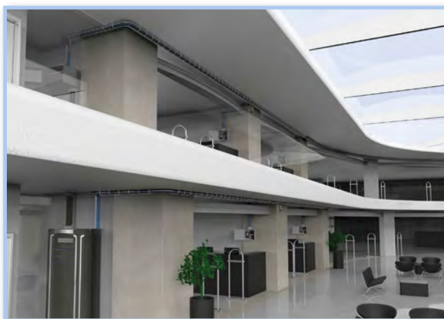
การติดตั้งสายภายในอาคาร
